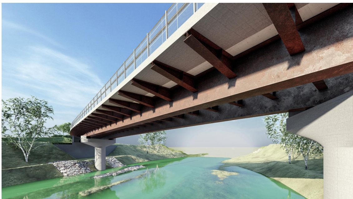
Dettaglio dell'orditura delle travi in cor-ten
