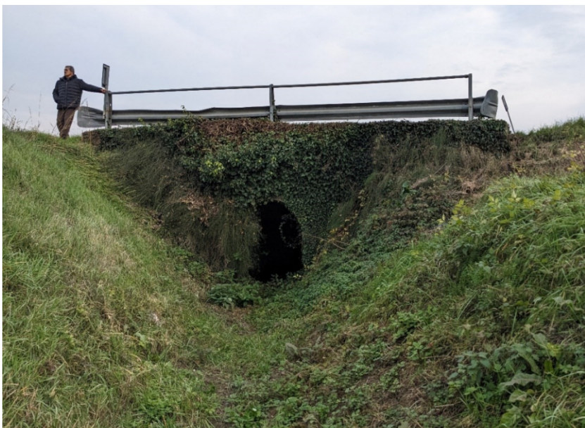
Immagine del tombinamento esistente dello scolo consorziale Fossola
